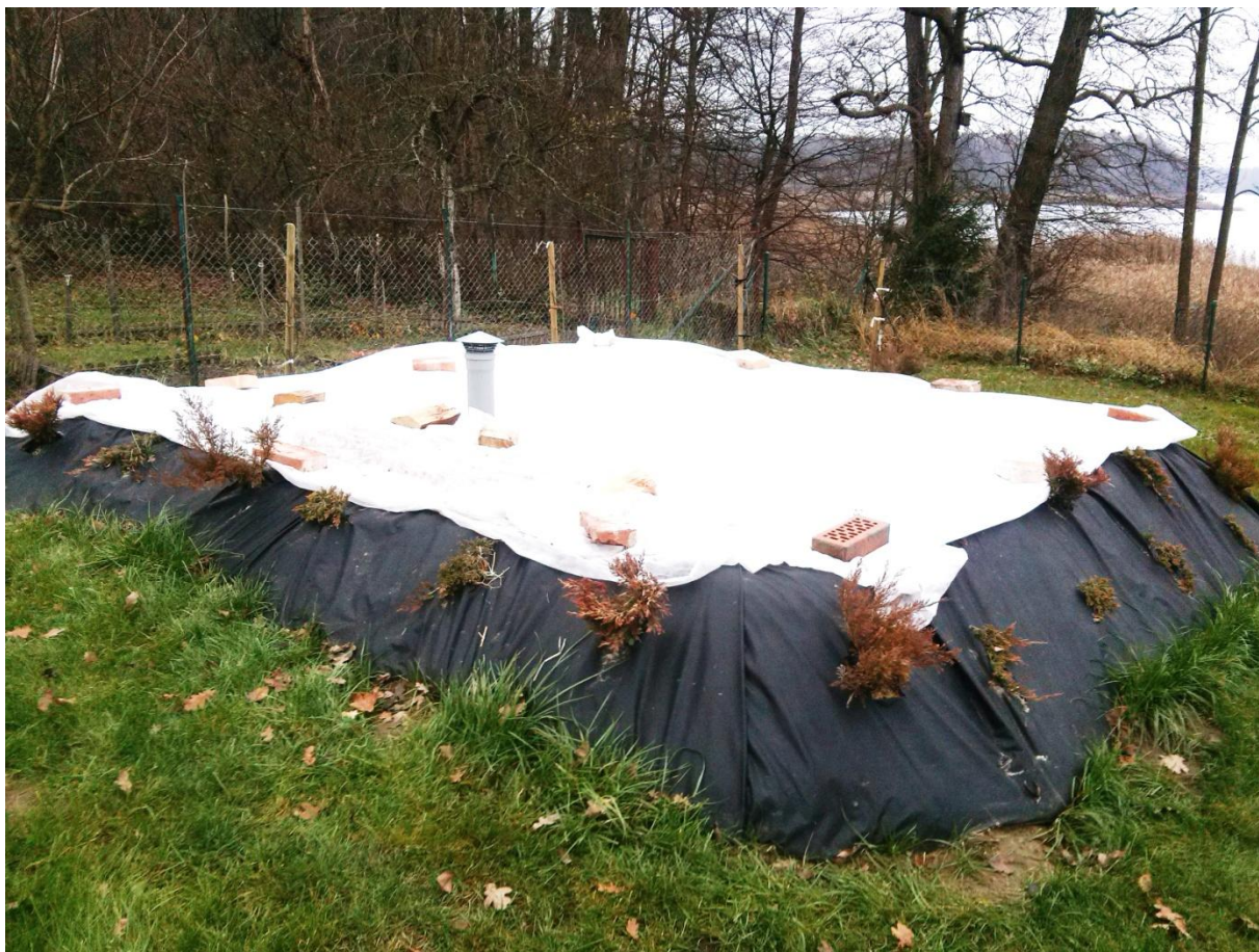
Rysunek 15. Oczyszczalnia hydrofitowa zabezpieczona na zimę źródło: zdjęcie własne, 2015r.
