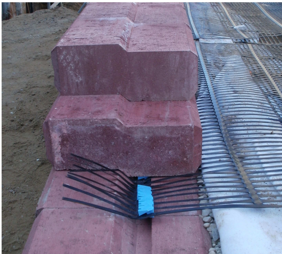
Rysunek 3. Mocowanie georusztu i łącznika
