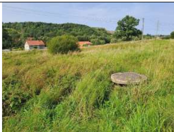
Istniejąca infrastruktura wodociągowa oraz elektroenergetyczna na działce 481. Widok na budynek 78
